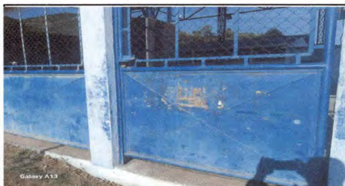
Foto 3: Mantenimiento en exterior e interior de estructura. Lijado y aplicación de pintura en puertas y portones en el módulo de pintura.
