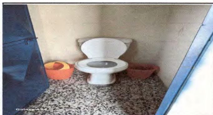
Foto 3: Cambio de tasas en el módulo de baños
