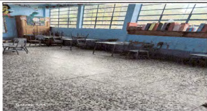
Foto1: Sustitución de piso en el módulo de aulas
