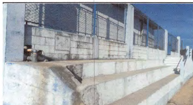
Foto 4: Pintura en exterior de muros de todo el circulado del establecimiento en el módulo de pintura
