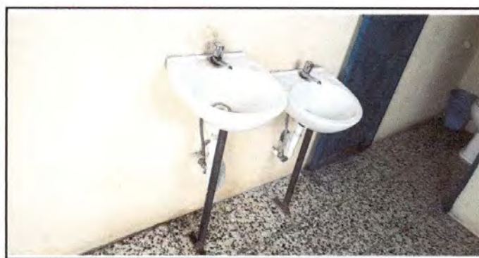
Foto 5: Sustitución de piso en el módulo de baños
