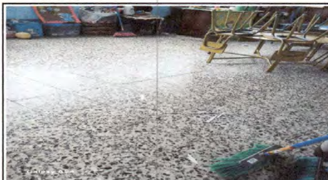
Foto 4: Pulido de piso en una aula en el módulo de aulas
