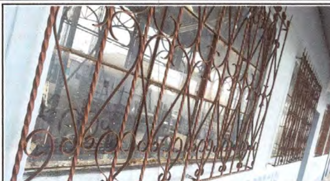
Foto 2: Sustitución y mantenimiento en lijado y pintura de balcones en el módulo de aulas
