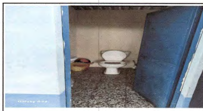
Foto 4: Mantenimiento de estructura de metal lijado y aplicación de pintura a puertas en el módulo de baños
