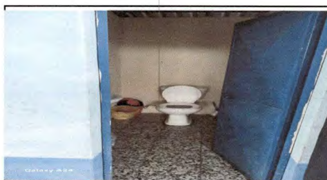
Foto 6: Pintura en exteriores e interiores en módulo de baño
