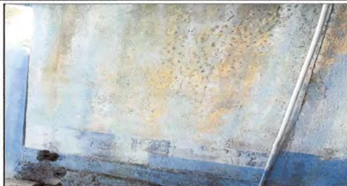
Foto 1: Pintura en exterior e interior de todo el circulado del establecimiento en el módulo de pintura.
