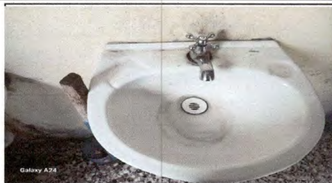
Foto 2: Cambio de lavamanos en el módulo de baños
