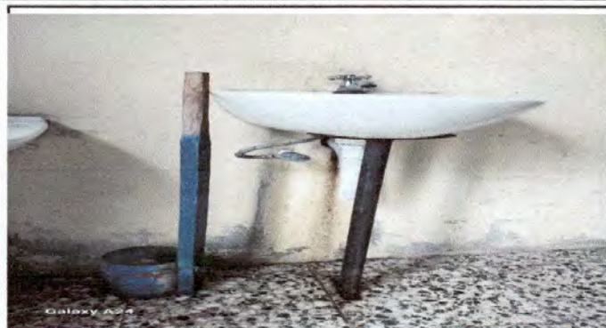
Foto1: Cambio de lavamanos en el módulo de baños
