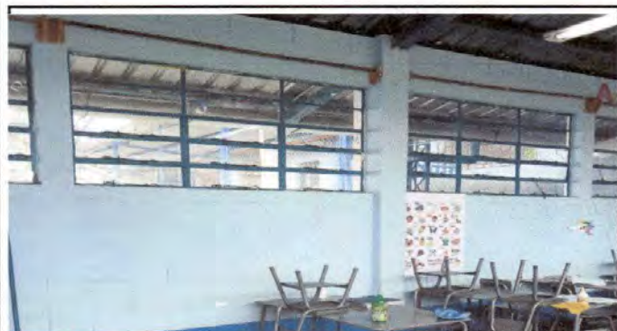
Foto 3: Pintura en paredes de exteriores e interiores en el módulo de aulas
