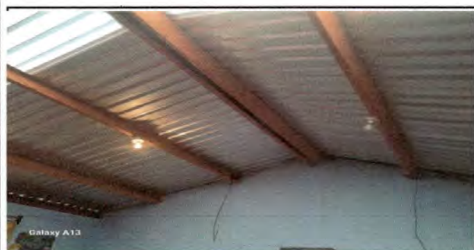
Foto 5: Sustitución de cableado eléctrico y plafoneras, en el módulo de aulas
