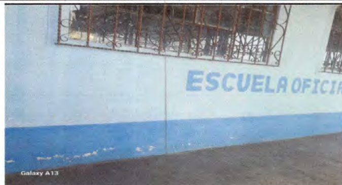
Foto 2: Pintura en exterior e interior de todo el circulado del establecimiento en el módulo de pintura.
